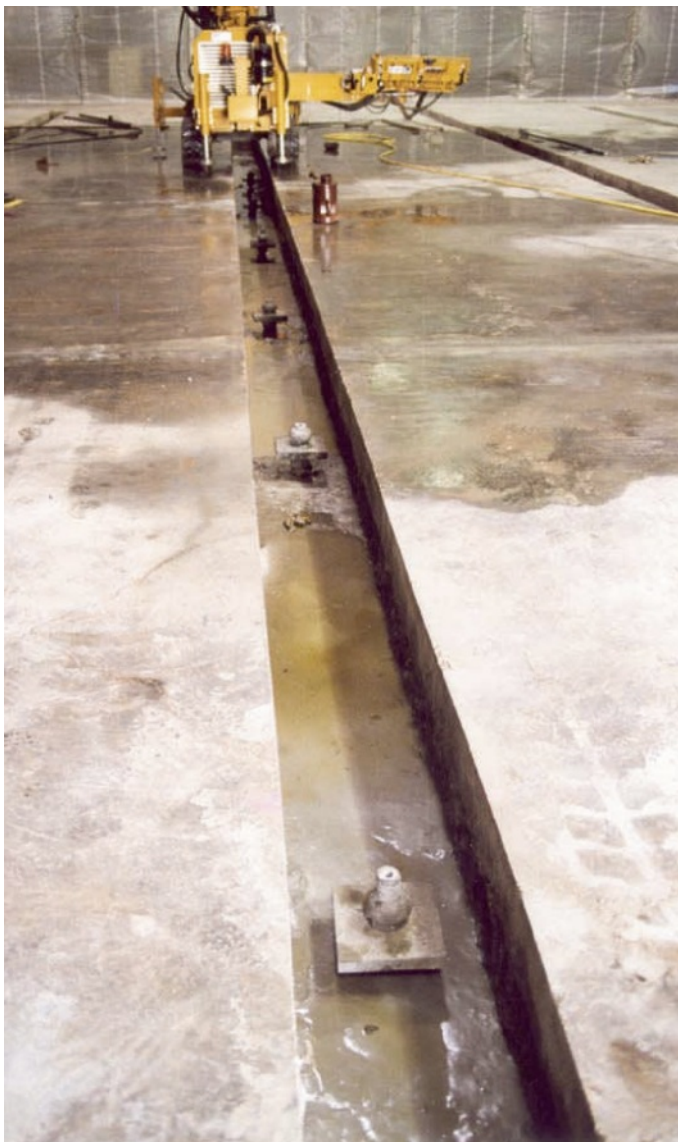
Fundamentverstärkung für Hochregallager
